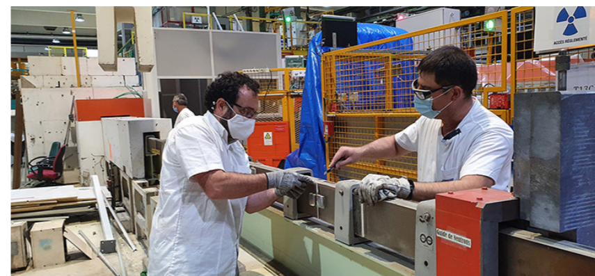
Activités durant l'arrêt de remplacement du doigt de gant H1 H2.
