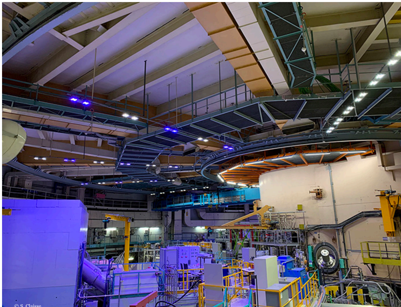
Niveau C du bâtiment réacteur.
