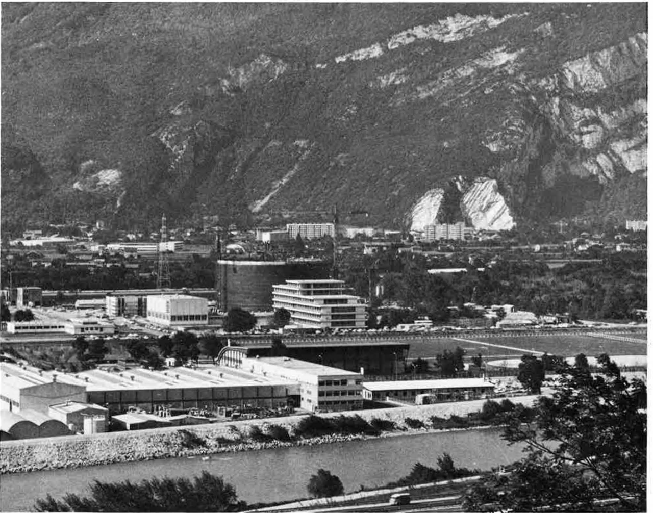
Vue générale du chantier (printemps 1970)
