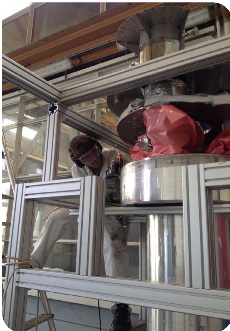
Figure 6.11 : Opération de découpe du bain d'hélium de HOPE
