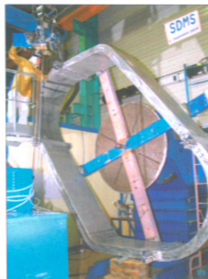
Soudage MIG forte énergie sur alliage d'aluminium épaisseur 125 mm
